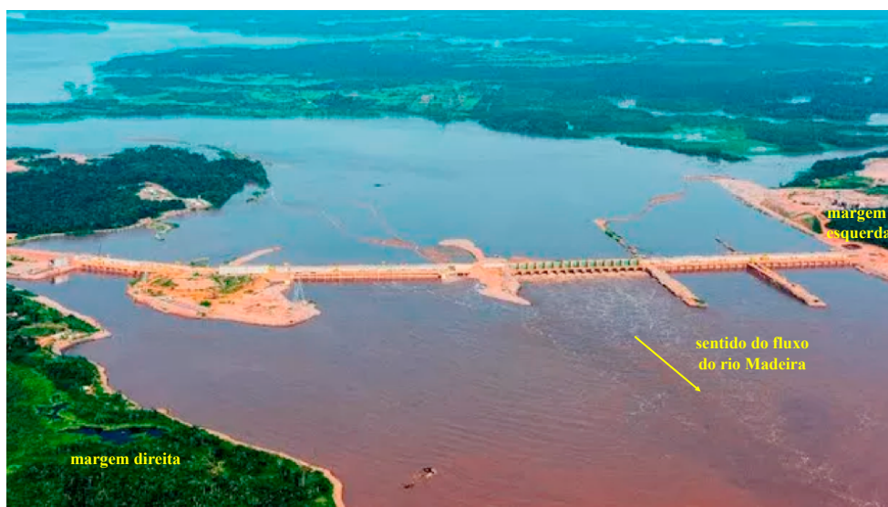
Figura 16 – Vista do arranjo geral da UHE Santo Antônio
